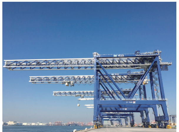
シャトルブーム式ガントリークレーン
